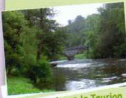
Ancien Pont sur le Taurion
